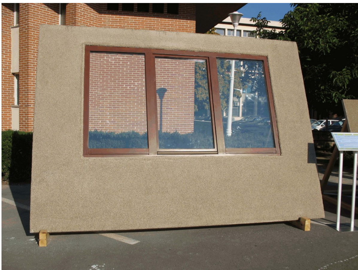
Fig.14. Panou de perete exterior (h=110 mm ; l = 3,3 m L = 5 m)
