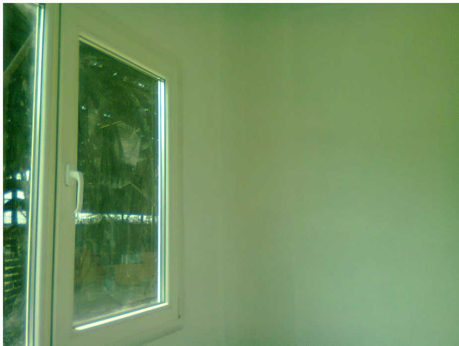
Fig. 26. Constructie realizata (dimensiuni 3x3x3 m). Interior
