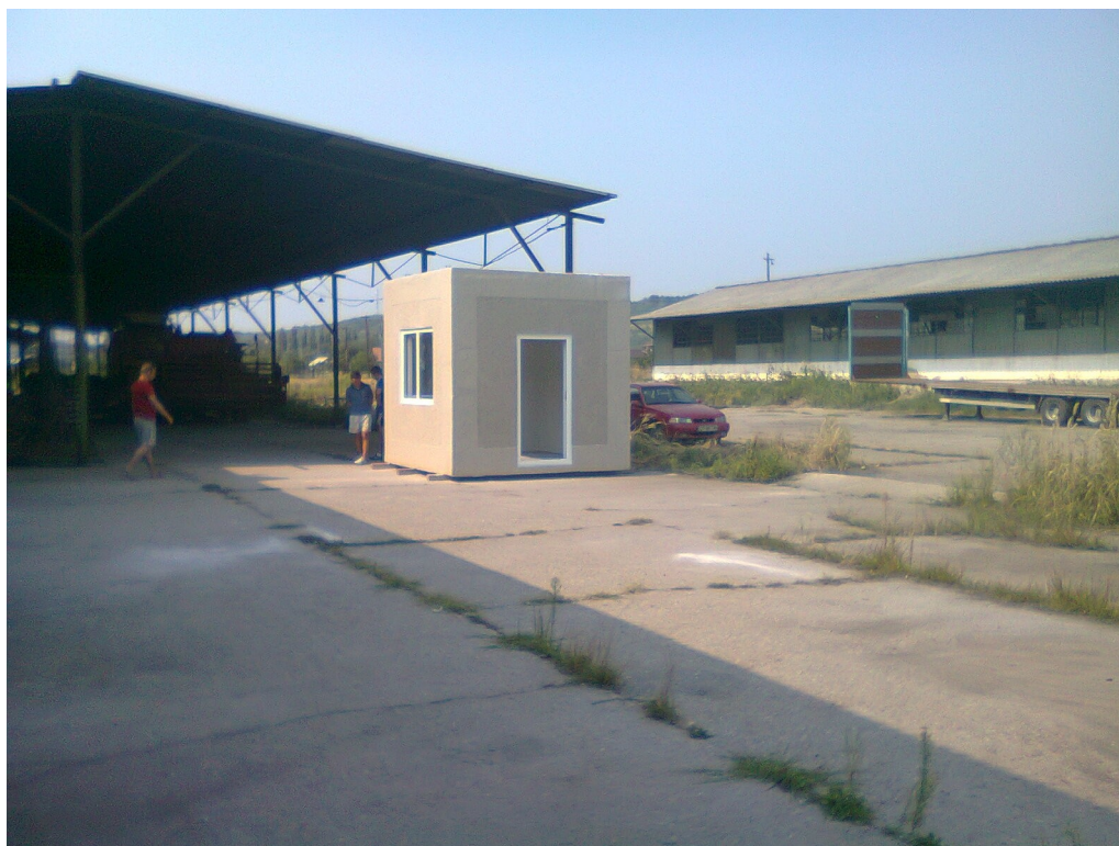
Fig.23. Constructie realizata (dimensiuni 3x3x3 m). Exterior 1
