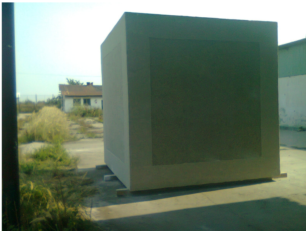
Fig.24. Constructie realizata (dimensiuni 3x3x3 m). Exterior 2
