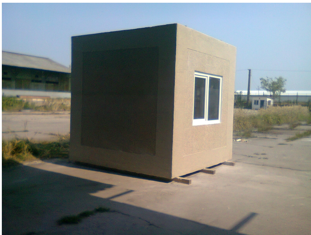
Fig.25. Constructie realizata (dimensiuni 3x3x3 m). Exterior 3
