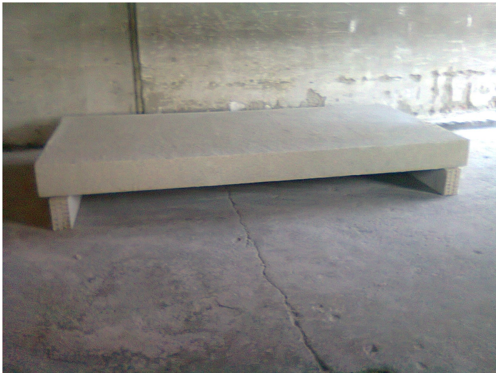
Fig. 9. Panou pentru poduri pietonale ( h = 200 \text{ mm} ; l = 1,5 \text{ m} ; L = 3,5 \text{ m} )
